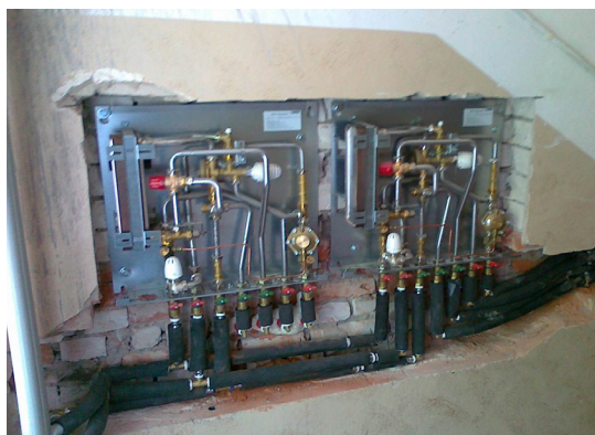
Slika 7. Ugradnja grejnih stanica
