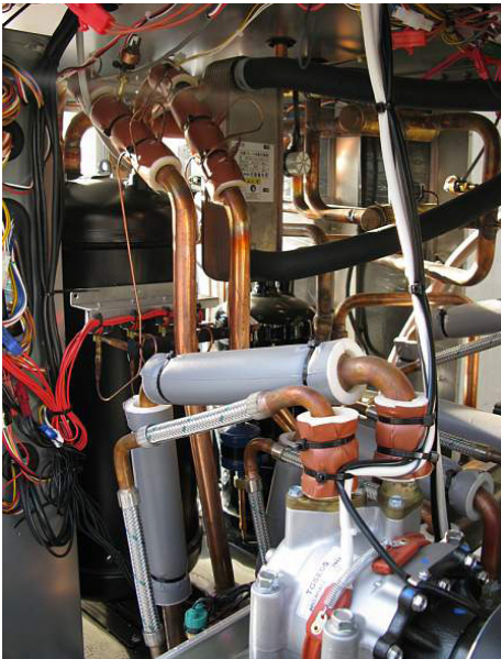
Slika 9. Deo kondenzatorskog agregata gasne toplotne pumpe
