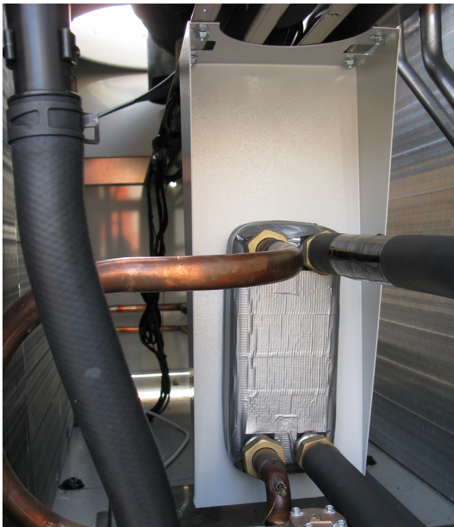
Slika 6. Pločasti razmenjivač toplote za pripremu sanitarne tople vode
