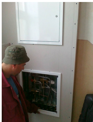
Slika 8. Ugradnja grejnih stanica
