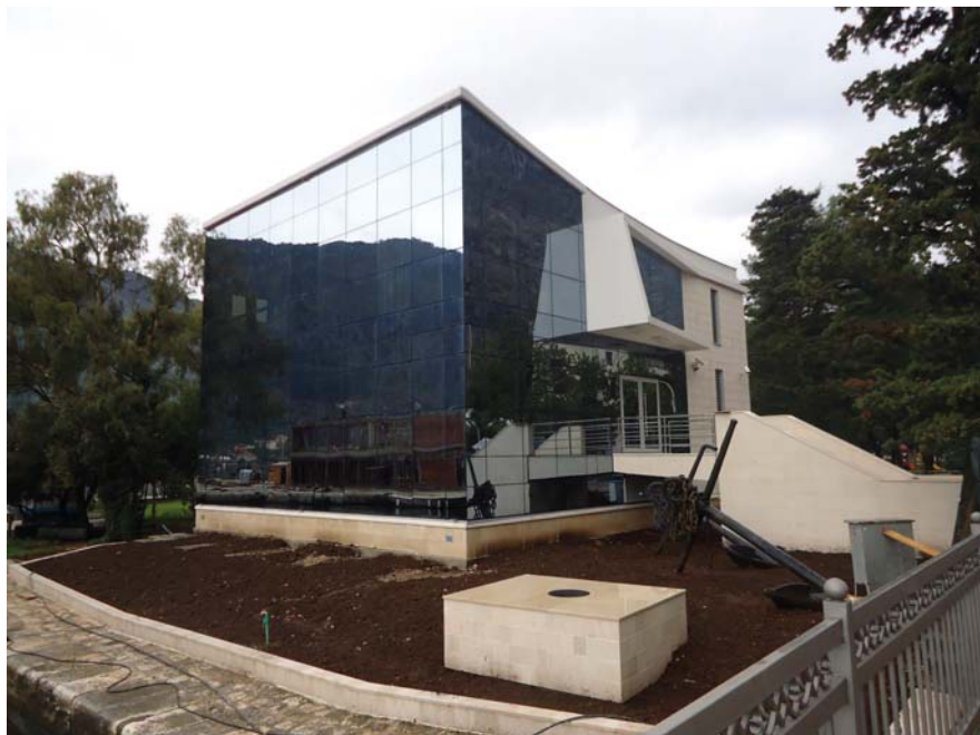
Upravna zgrada preduzeća "Luka Kotor", koja će biti završena krajem februara 2014.
