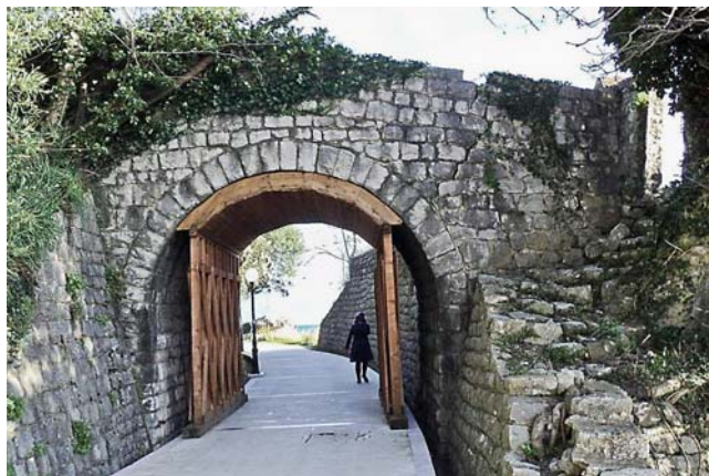
Izgled mosta 2012. godine, neposredno prije sanacije, sa drvenom oplatom
