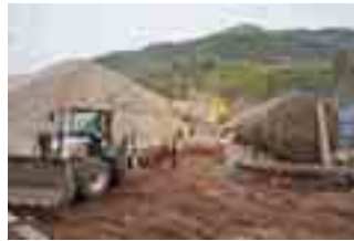
Sa gradilišta kompleksa Portonovi
