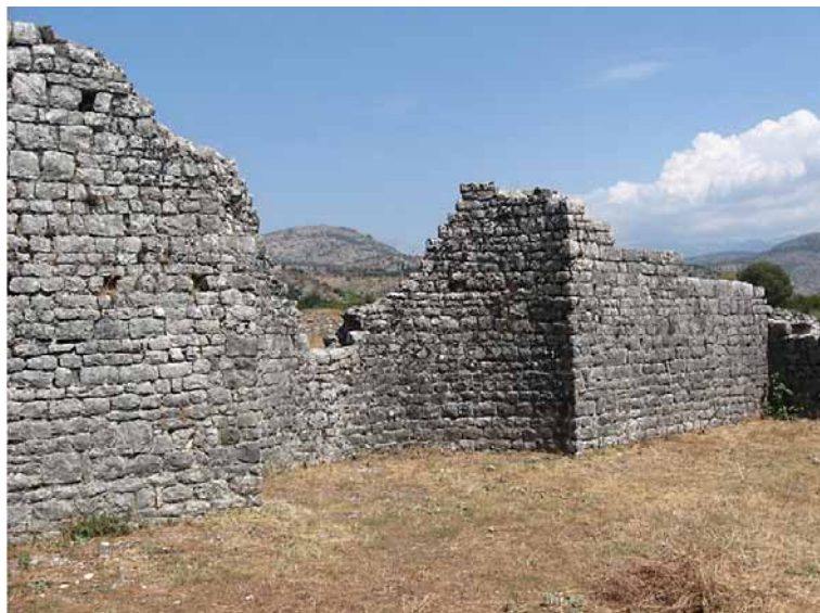
sl. 3. Zidno platno civilne bazilike sa unutrašnje strane
