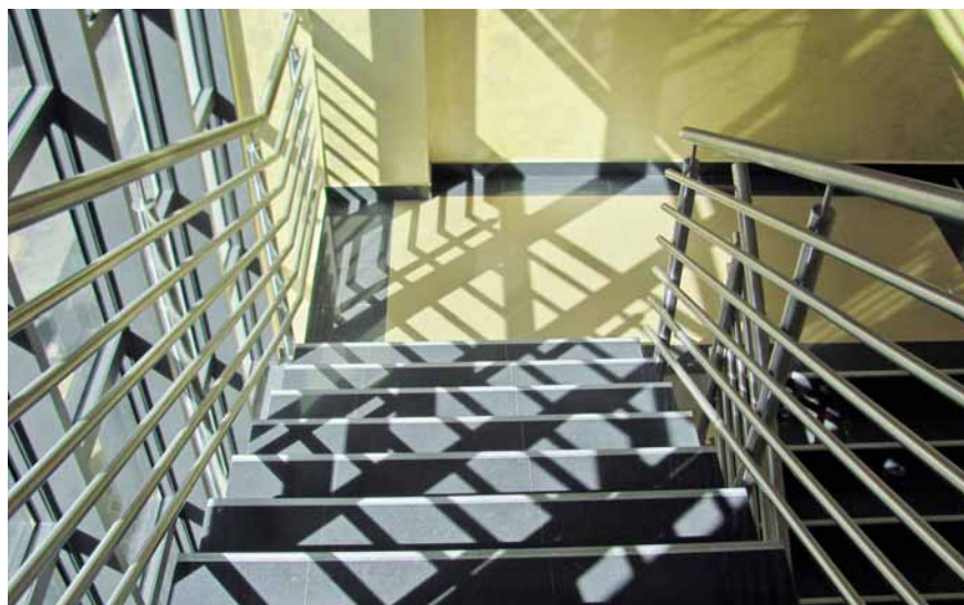
Stepenište ograde od ALU-cijevi
