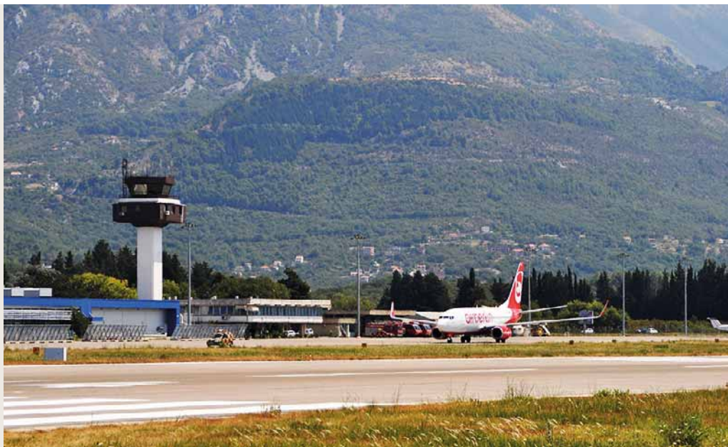
Rekonstrukcija postojećeg tornja
