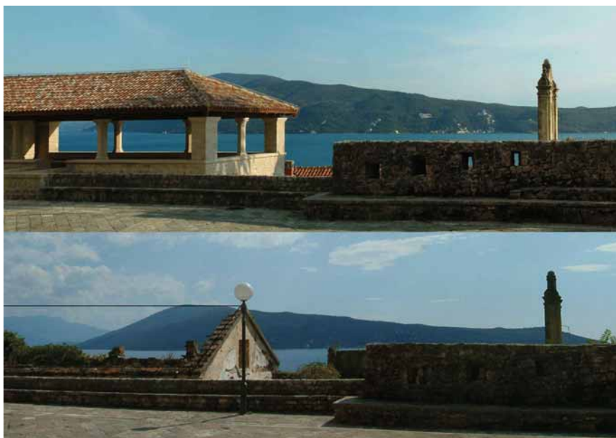
Zgrada Mletačke bolnice/Austrougarske kasarne prije i poslije intervencije, pogled sa Trga Mića Pavlovića
