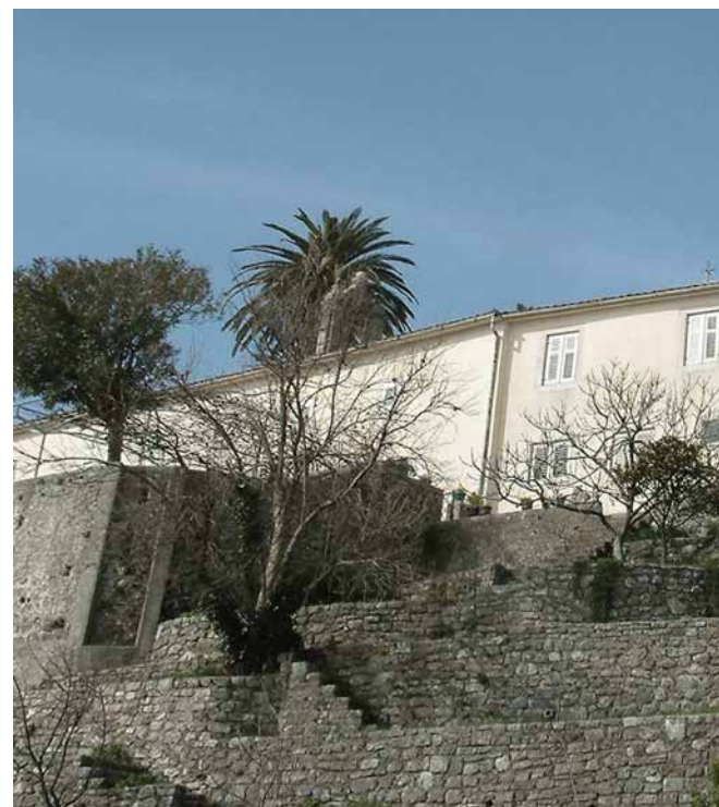
Zgrada Mletačke bolnice/Austrougarske kasarne, južna fasada
