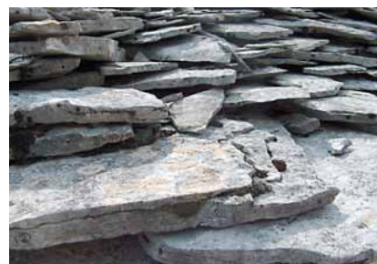
Kamene ploče u krovu
