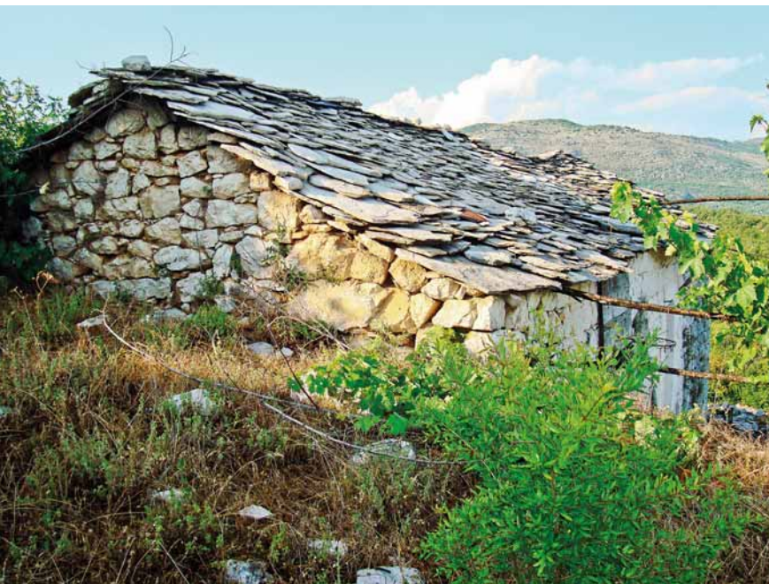
Stara kuća prizemljuša sa kamenim pločama, Đalci
