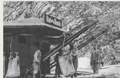
Izlazna tačka i mjesto za utovar materijalana žičaru stanice Škudra foto: radiodux.me
