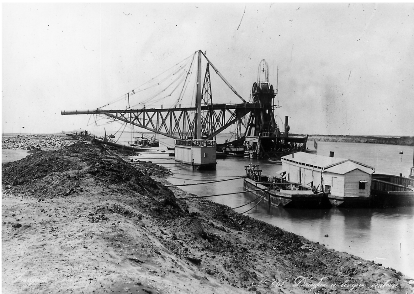
Izgradnja Sueckog kanala
