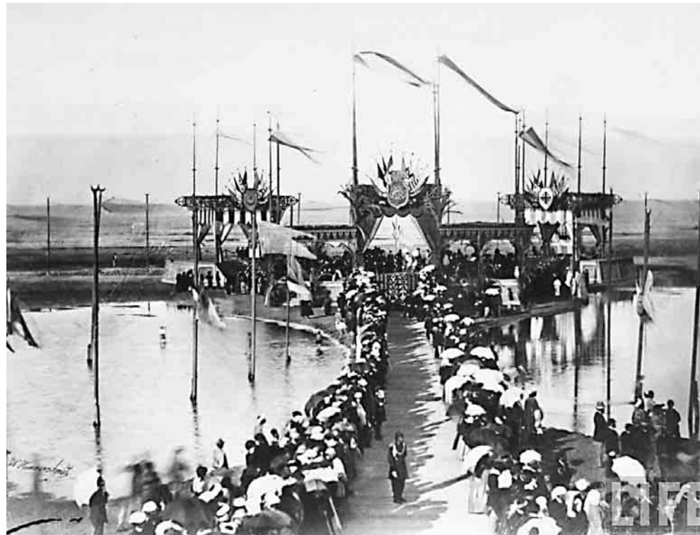
Sa otvaranja kanala
