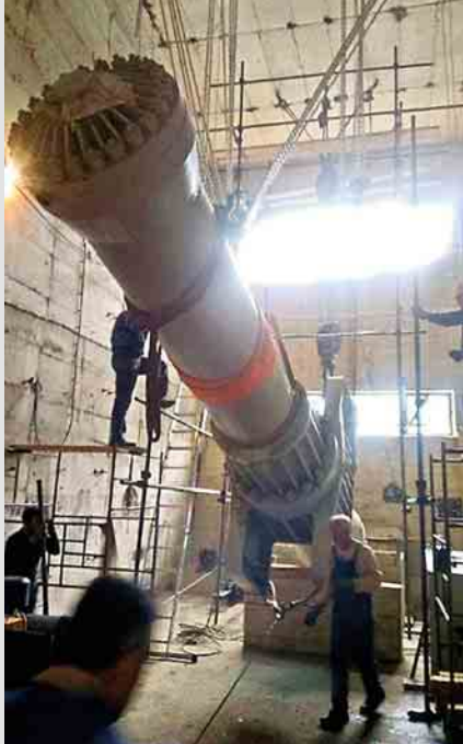
Izvučen i okrenut servomotor, foto: Privatna arhiva
