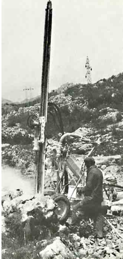
Radnici OGP "Titograd" na izgradnji puta Titograd -Cetinje-Budva
