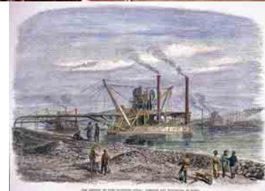
Tokom gradnje kanala
