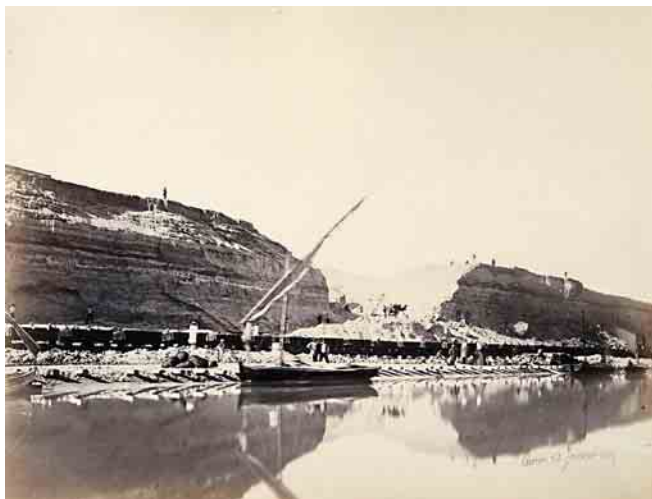
Tokom gradnje kanala
