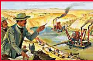
Inženjeri tokom kopanja kanala
