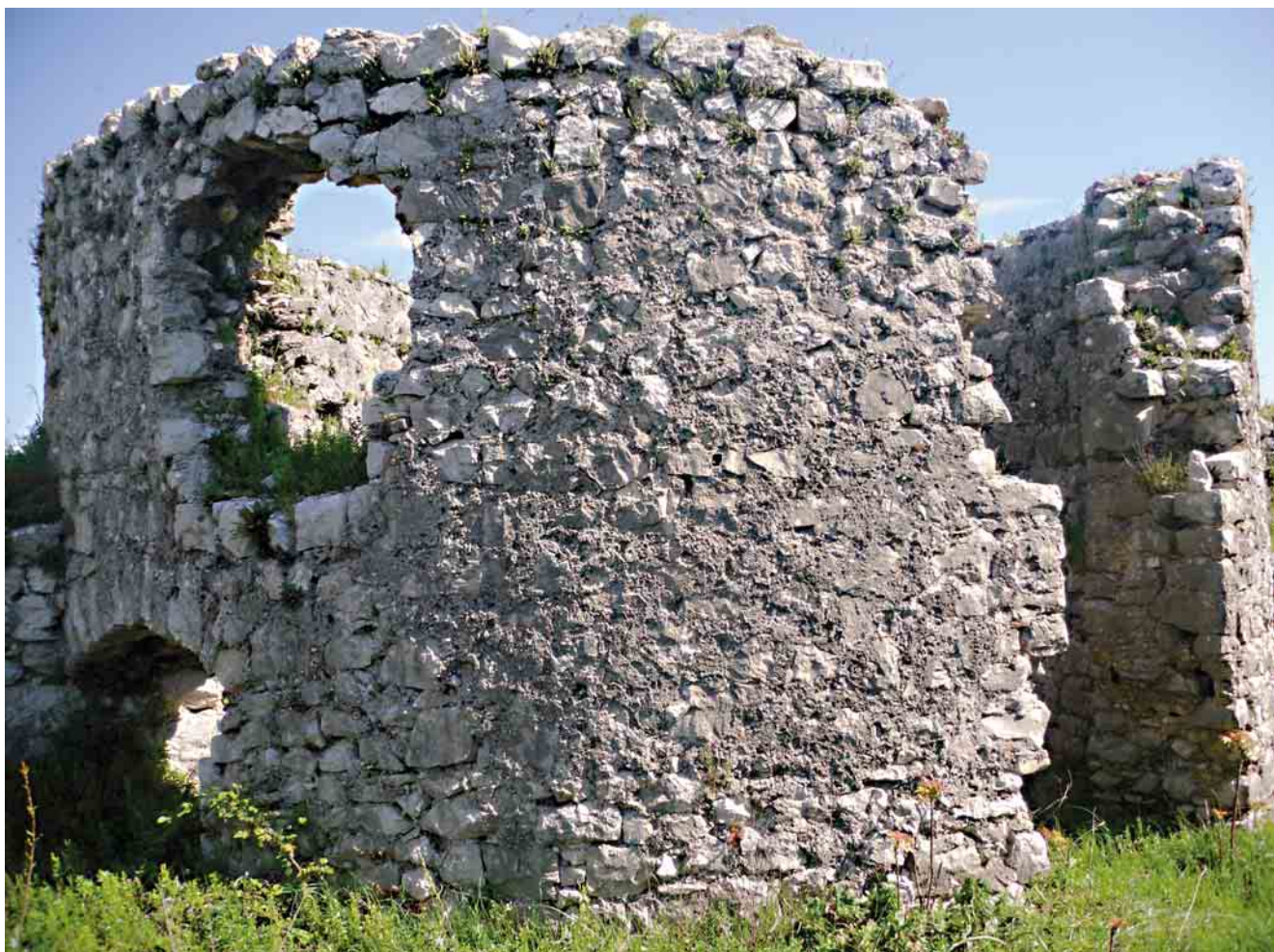
Razrušena kula u zapadnom dijelu tvrđave
