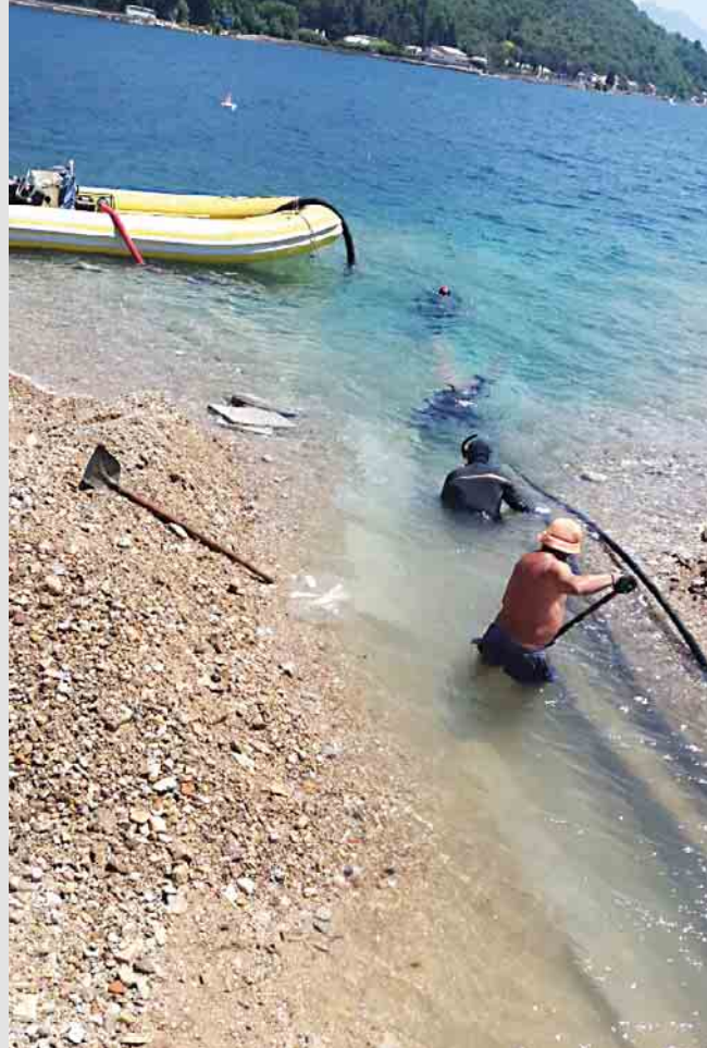
Polaganje kabla u priobalnoj zaštiti
