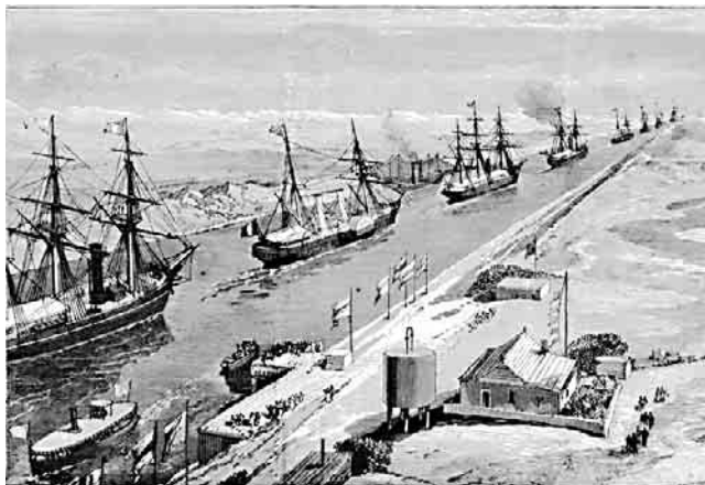
Brodovi u kanalu
