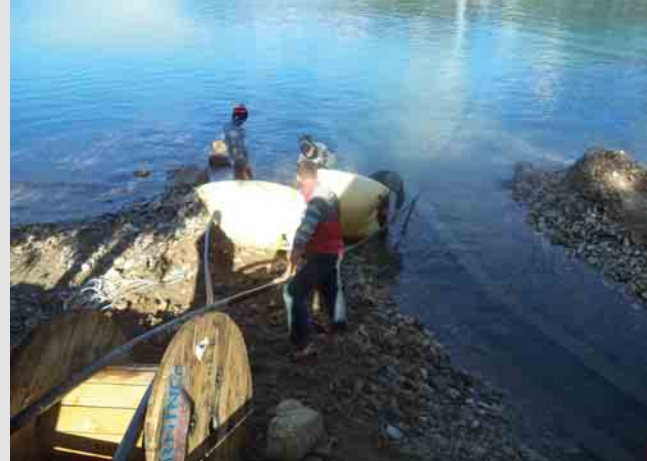
Povezivanje kabla sa plutajućim elementima
