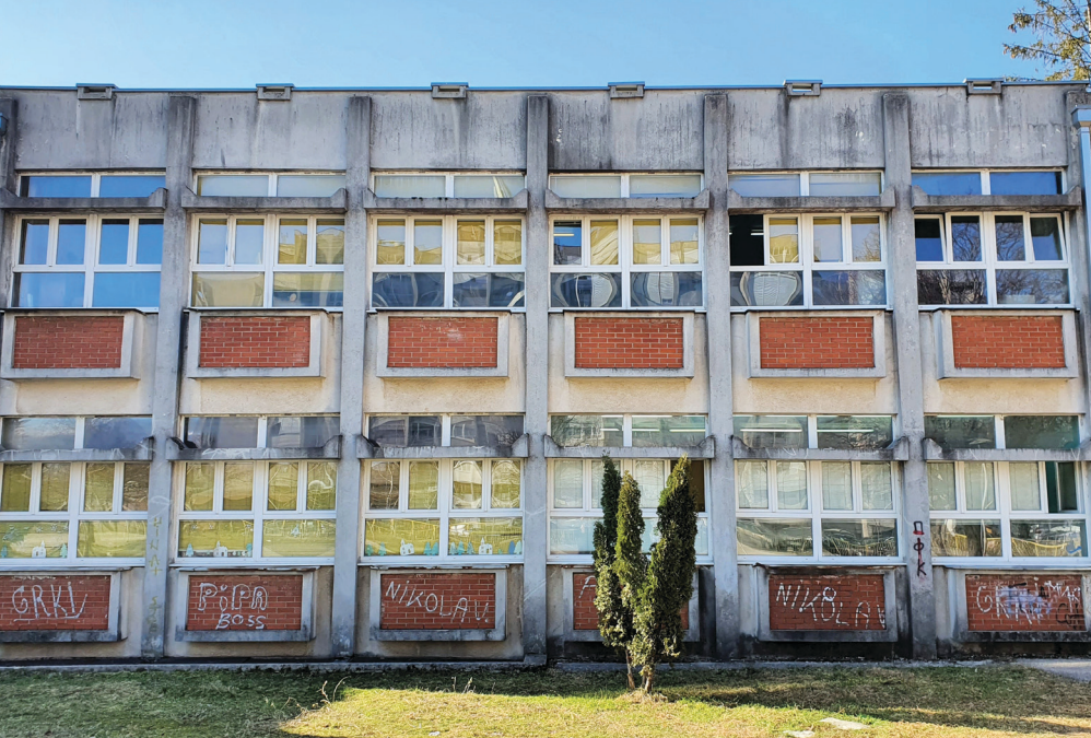
Fasadni parapetni ispusti sa fasadnom opekom kao ispunom koji su zastupljeni na svim učionicama, foto: N. Bulajić
