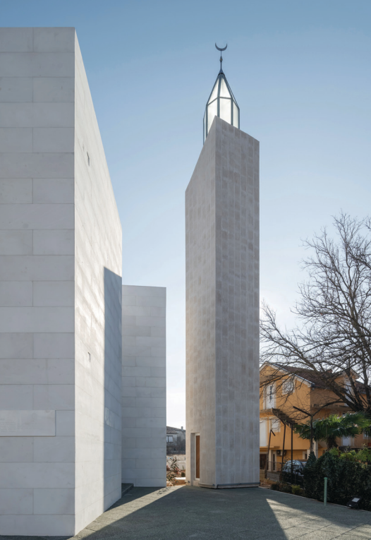
Minaret je kvadratnog presjeka i na završetku probija osmougaoni stakleni element, foto: ARHINGinženjering.me
