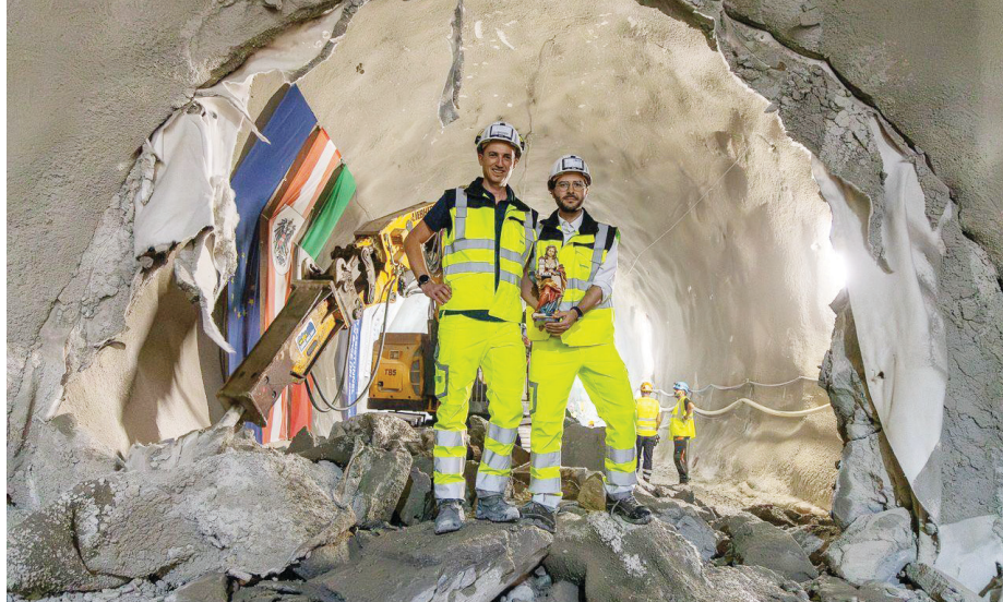
Tunel Brenner, jedan od najvećih infrastrukturnih projekata na kontinentu, foto: cdn.ca.emap.com
