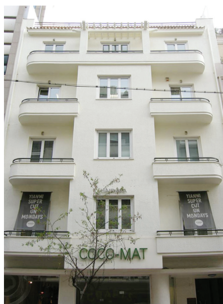
Sl. 9. Stambena zgrada Z. Lorentzatos, prije i poslije intervencije
