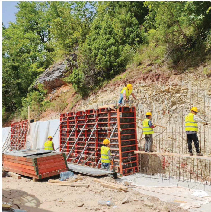
Na putu ka Žabljaku urađen je nov potporni zid u dužini oko 35m, foto: G. Šegrt
