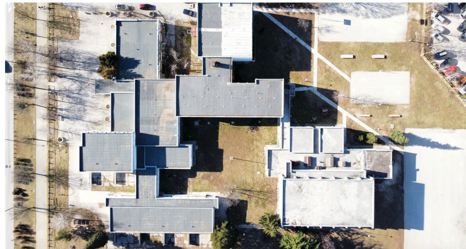
Krovne površine dobile su novi hidroizolacioni sloj, foto: N. Bulajić
