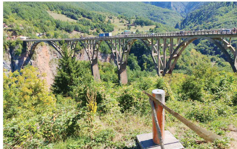
Radovi na sanaciji i rekonstrukciji otpočeli su sedmog jula 2025, foto: G. Šegrt
