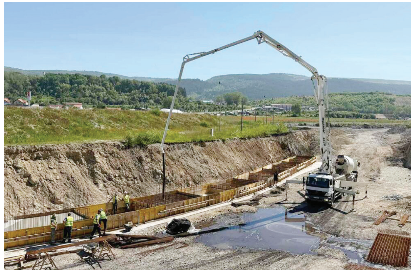
Radovi na zahtjevnom projektu izmiještanja rijeke Čehotine, foto: Rudnik uglja Pljevlja
