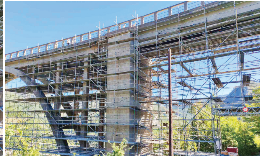
Izrada skele za fizički pristup svim elementima mosta, foto: G. Šegrt
