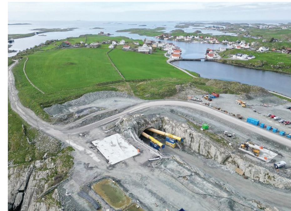
Radovi na izgradnji počeli su još 2018, foto: Øyvind Ellingsen
