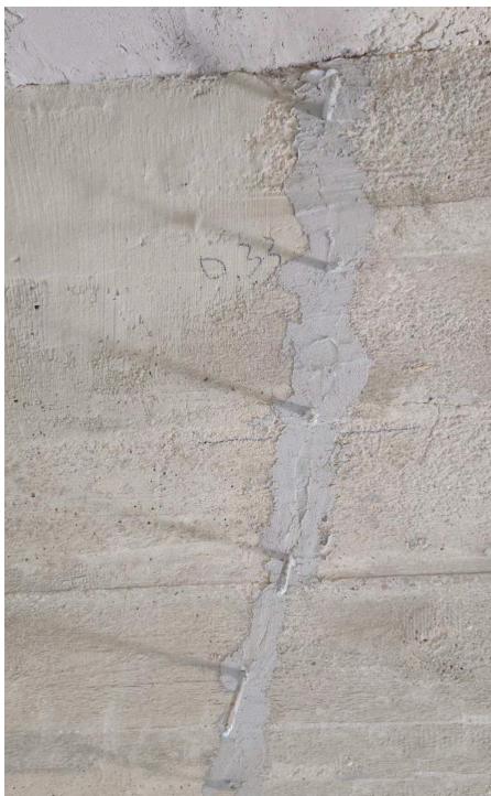
Ispitivanje i injektiranje pukotina na mostu, foto: G. Šegrt
