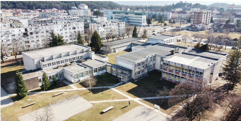
Osnovna škola „Luka Simonović“ nakon sanacije i rekonstrukcije, foto: N. Bulajić
