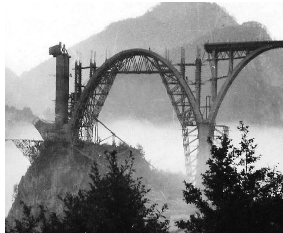
Drvena skela za potrebe izgradnje mosta na Tari, foto: gradnja.me
