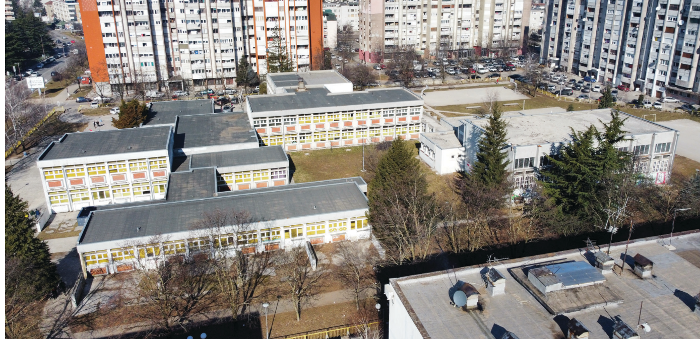
Najveći izazov bio je pronalazak adekvatnog rješenja – sistema termoizolacione fasade, foto: N. Bulajić
