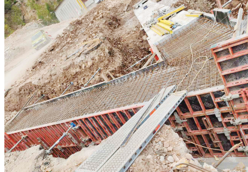
Novi prpusti ispod puta, foto: G. Šegrt
