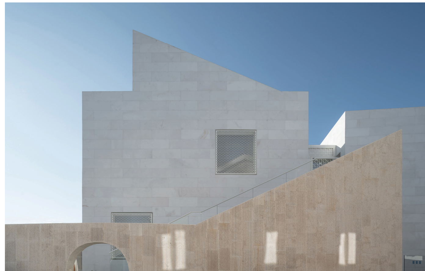
Na džamiji je primijenjen kamen kao obloga objekta džamije i ograde, foto: ARHINGinženjering.me
