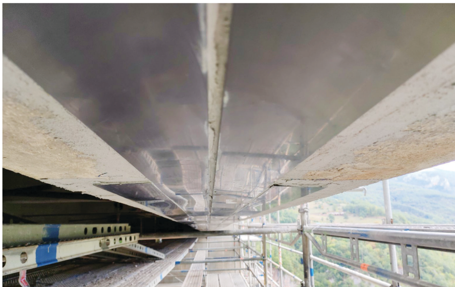
Ojačanje konstrukcije lakim trakastim materijalom od karbonskih vlakana, foto: G. Šegrt
