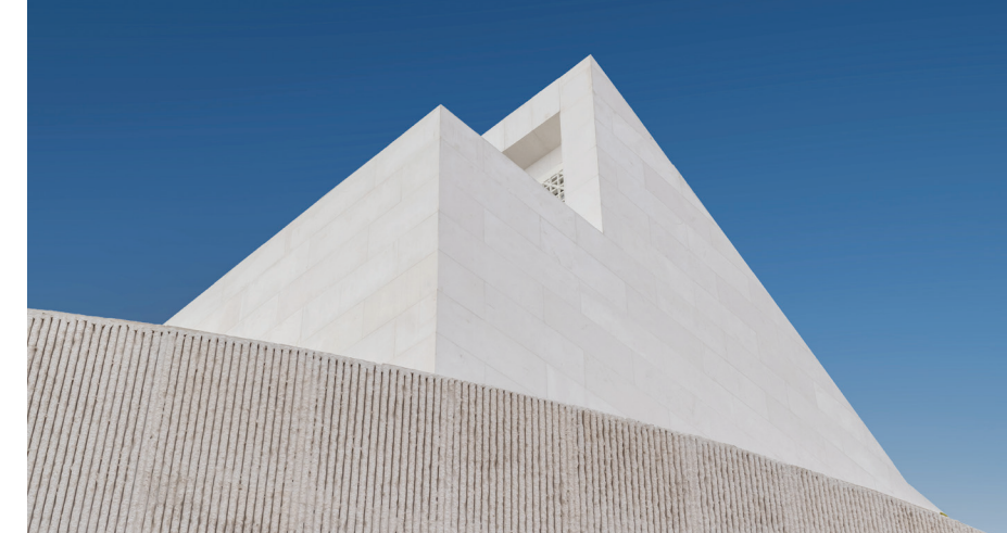
Fasada je obložena bijelim, glačanim kamenom, a ograde i minaret vertikalno frezanim kamenim pločama, foto: ARHINGinženjering.me
