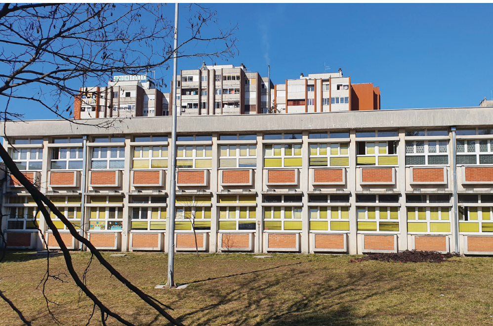
Izrada izolacije nije dolazila u obzir zbog gubitka definisanog arhitektonskog elementa – korpusa sa fasadnom opekom, foto: N. Bulajić
