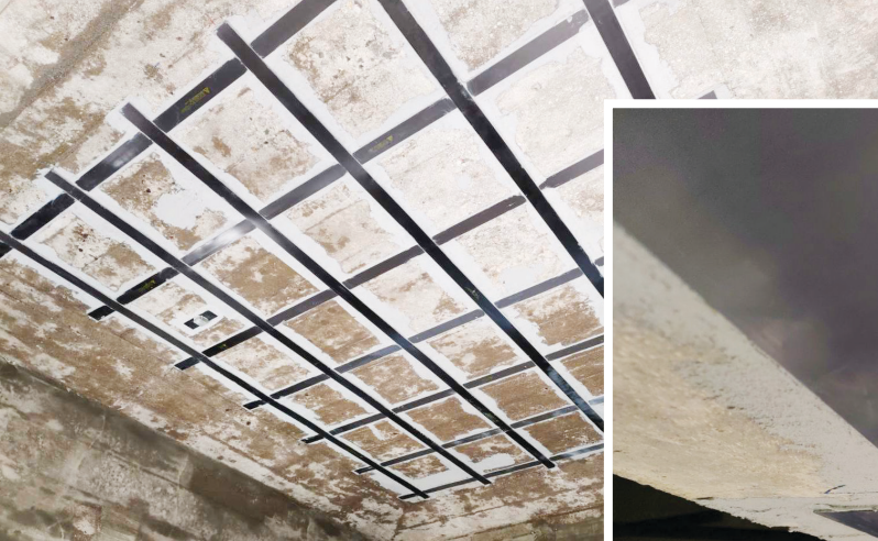
Ojačanje konstrukcije lakim trakastim materijalom od karbonskih vlakana, foto: G. Šegrt
