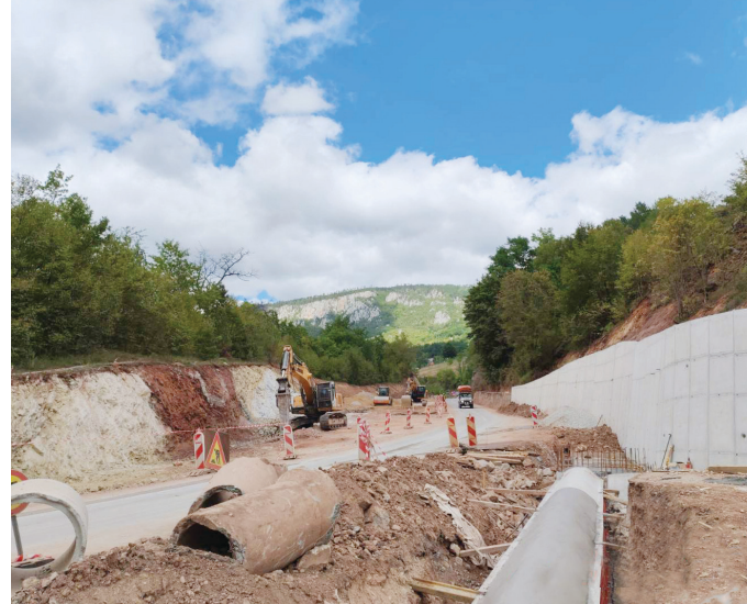
Radovi na putu ka Pljevljima, foto: G. Šegrt
