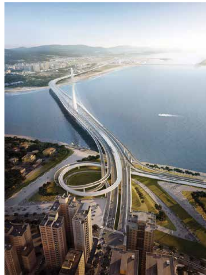
Most dug 920m ima samo jedan pylon koji je visok 200m, foto: www.zaha-hadid.com
