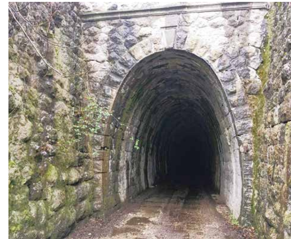
Tunel kroz Sutorman je čitavom dužinom obložen kamenom, foto: foto: https://dd-shaz.blogspot.com/2017
