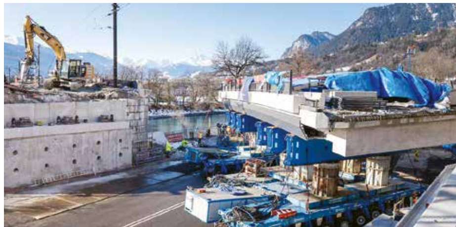
Operacija pomjeranja mosta, foto: oekastatic.orf.at
