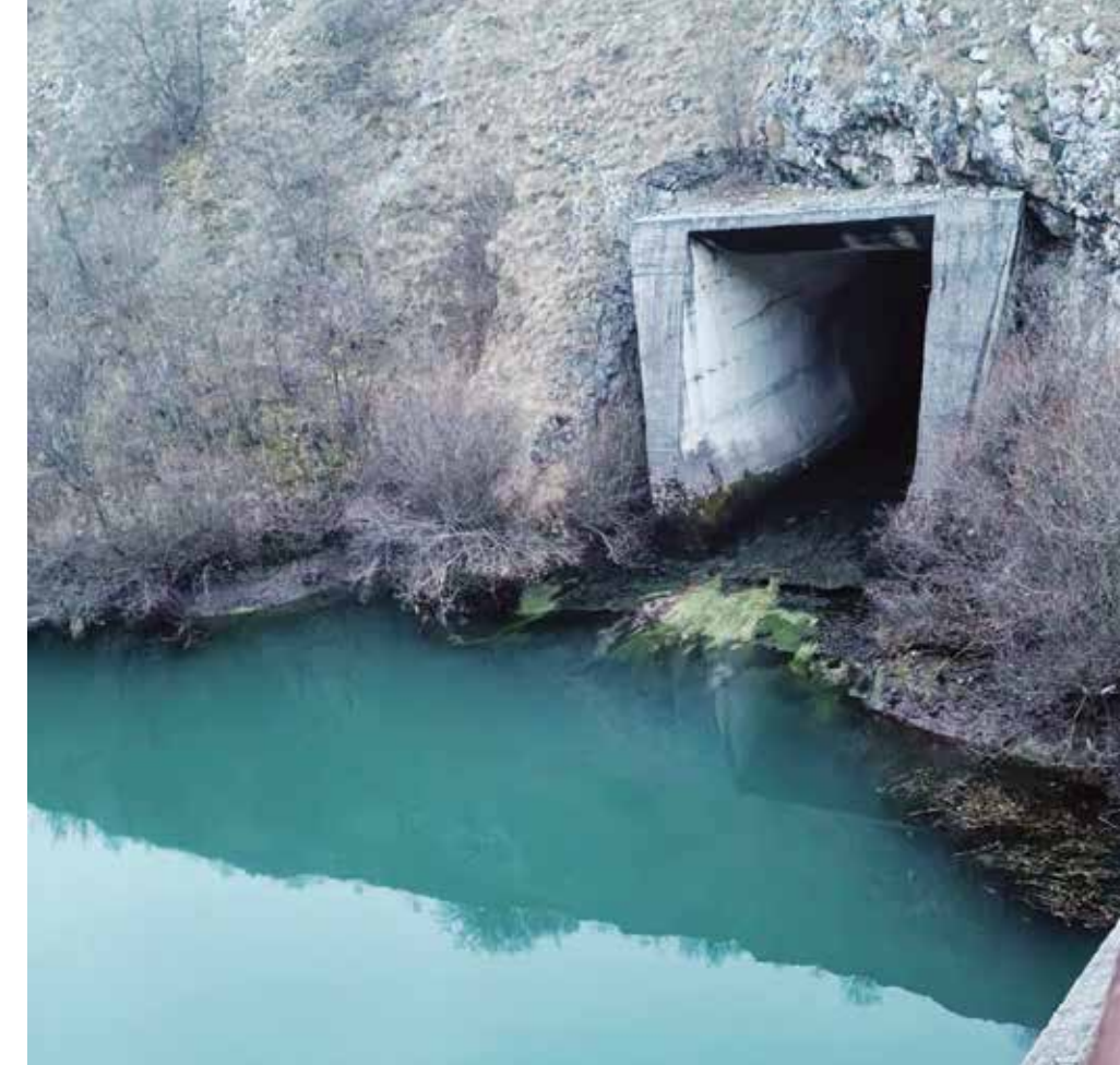
Tunel Rudine, foto: Privatna arhiva
