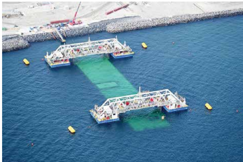
Potapanje betonske sekcije tunela, foto: femern.com
