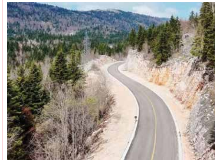
Asfaltirana dionica Zaborje-Jasenovo Polje, foto: Uprava za saobraćaj Crne Gore
