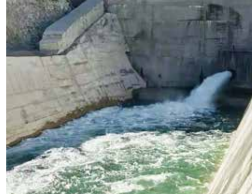
Završeno testiranje brana na novom koritu Čehotine, foto: rupv.me
