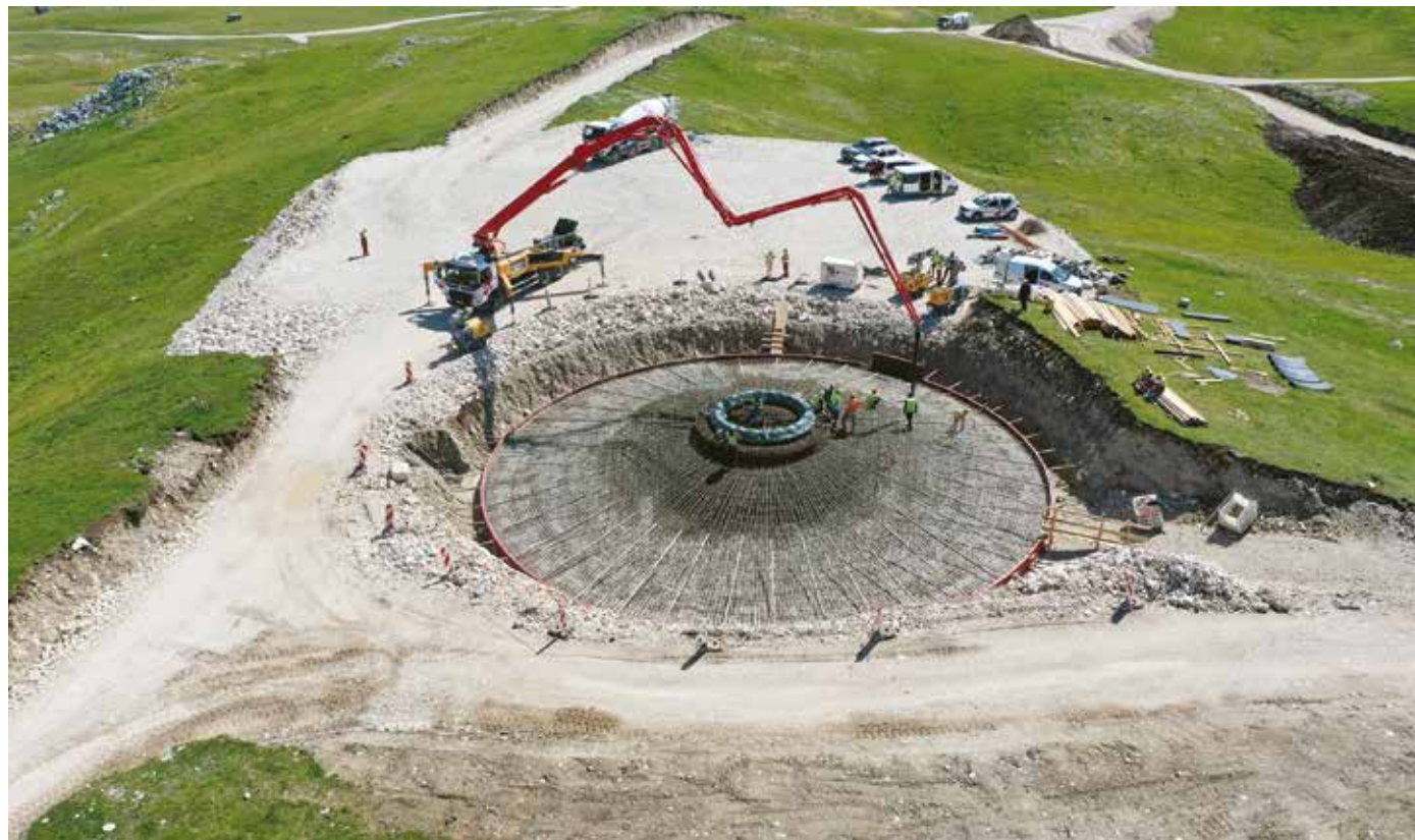
Izliavanje temelja za turbine, foto: epcg.me / Zoran Đurić
