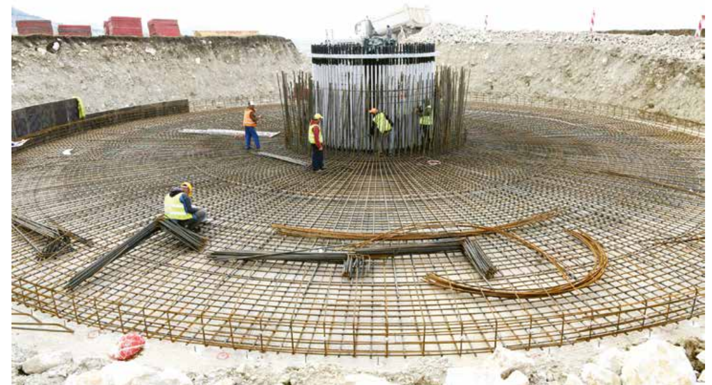
Radovi koji su prethodili postavljanju turbina, foto: epcg.me/Zoran Đurić
