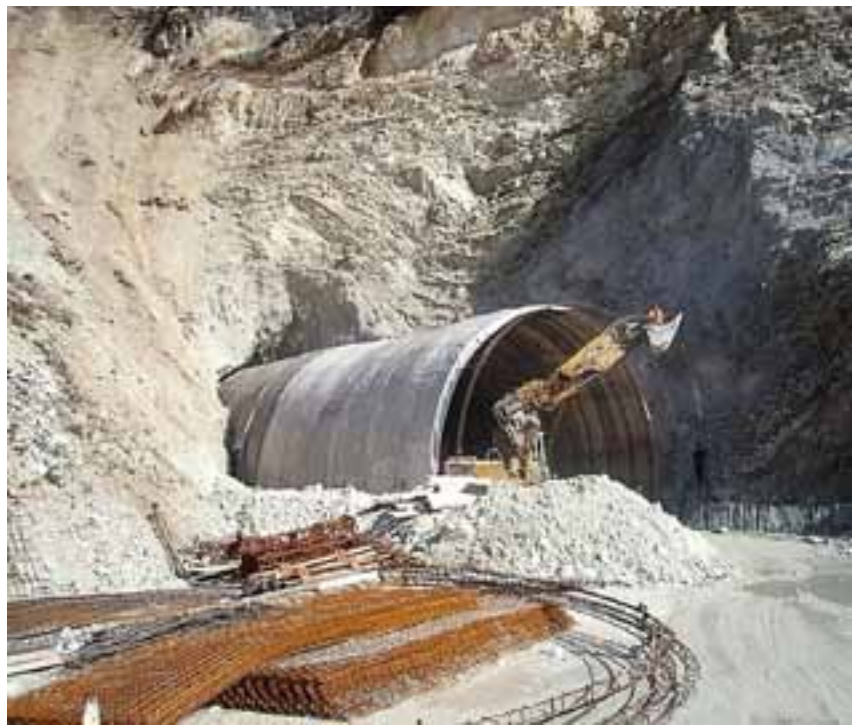
tunnel Ivica u izgradnji
