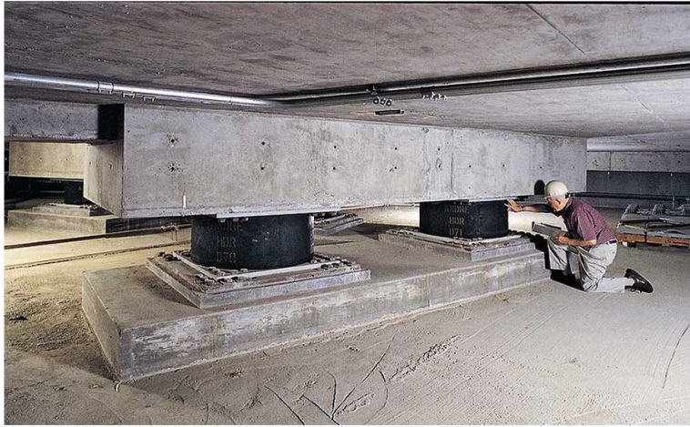
Bazna izolacija od elastičnog polimera
