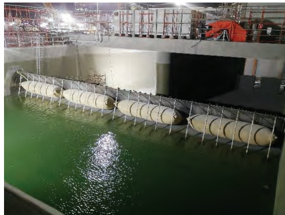
Slika 1. Gumena brana na naduvavanje
