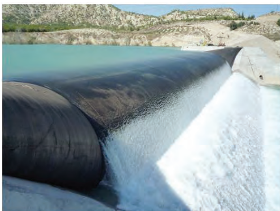
Slika 2. “Spillway gate” u izgradnji
