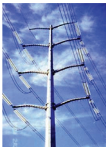
Sl. 13. Izgled novog stuba 400 kV DV
