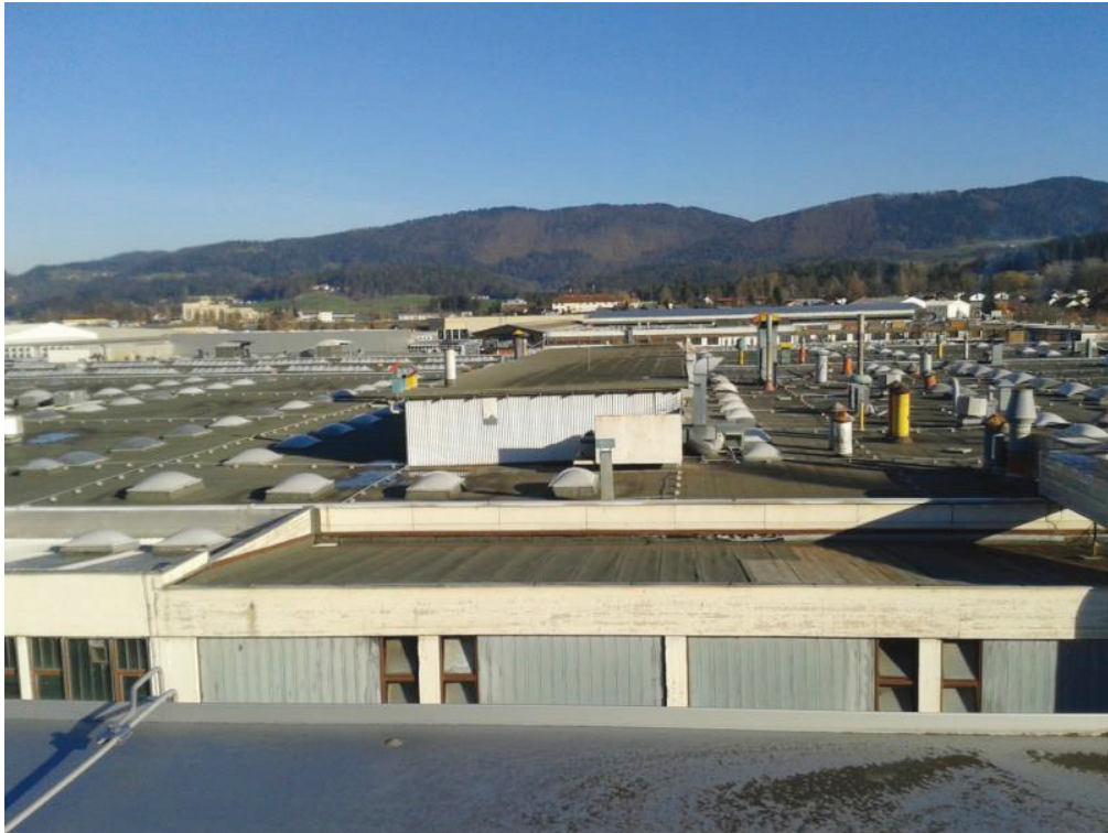
Slika 11: Izvedena mreža dimenzija 10 x 10m samo na dijelu objekta.
