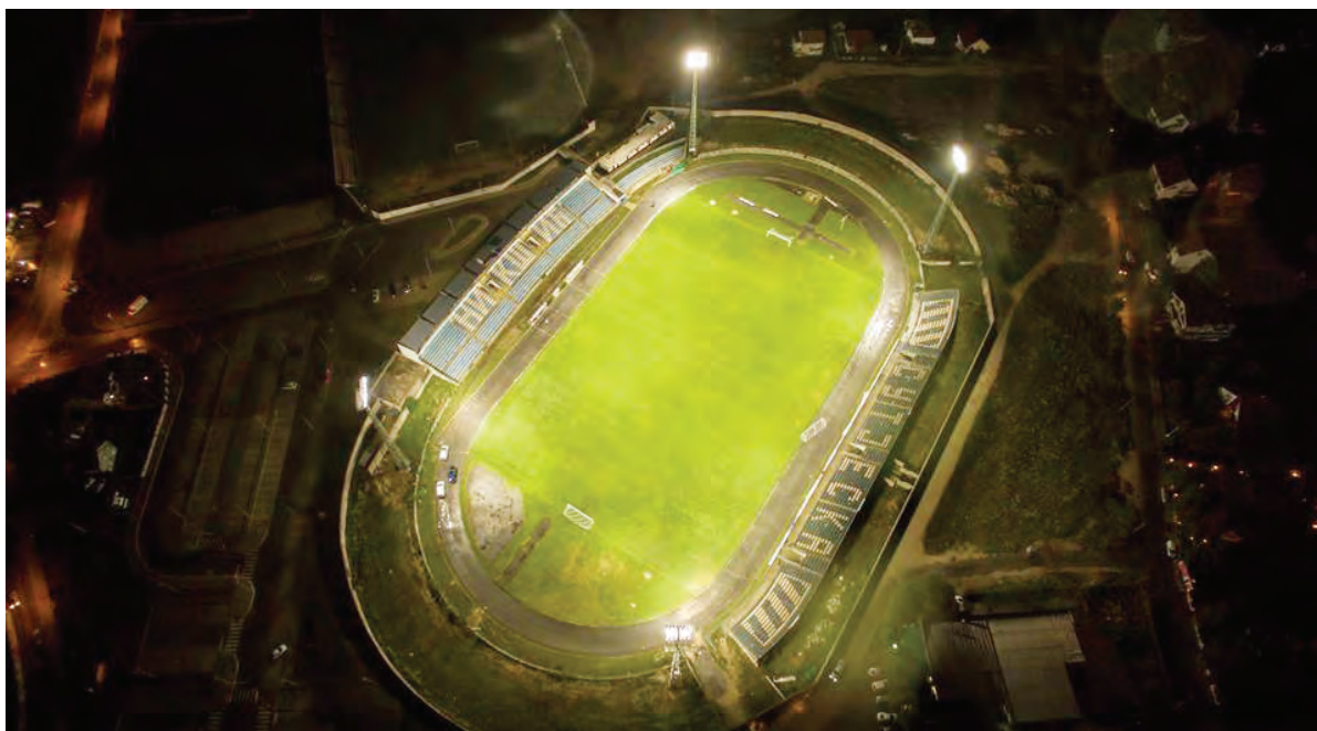
Slika 1. Instalacija osvetljenja Gradskog stadiona u Nikšiću
