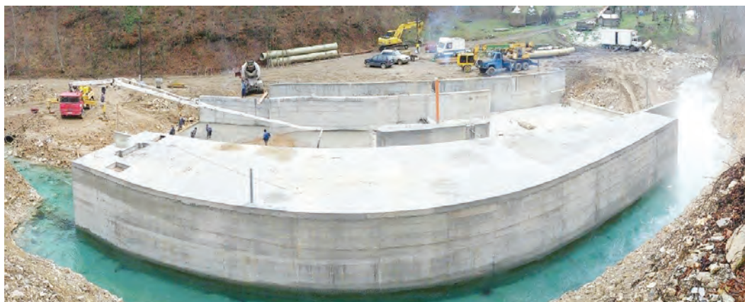
Slika 4. Objekat vodozahvata u toku izgradnje - mHE „Bistrica Majstorovina”, I dio
