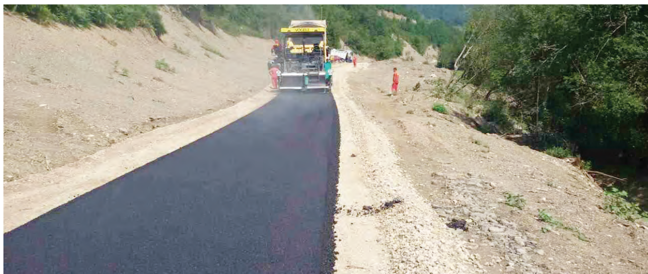
Slika 12. Asfaltiranje lokalnog puta
