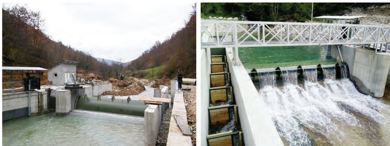
Slika 5. Objekat vodozahvata u toku izgradnje - mHE „Bistrica Majstorovina”, II dio
