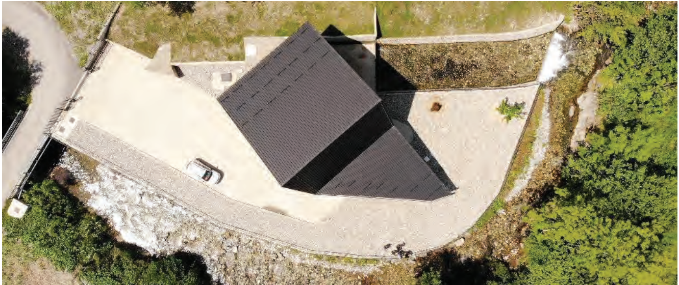
Slika 11. Objekat mašinske zgrade nakon izgradnje - mHE „Bistrica Majstorovina“ II dio
