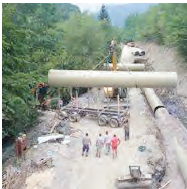
Slika 6. Objekat cjevovoda u toku izgradnje - mHE „Bistrica Majstorovina”
