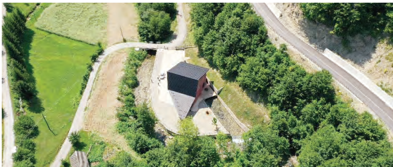
Slika 10. Objekat mašinske zgrade nakon igradnje - mHE „Bistrica Majstorovina“ I dio
