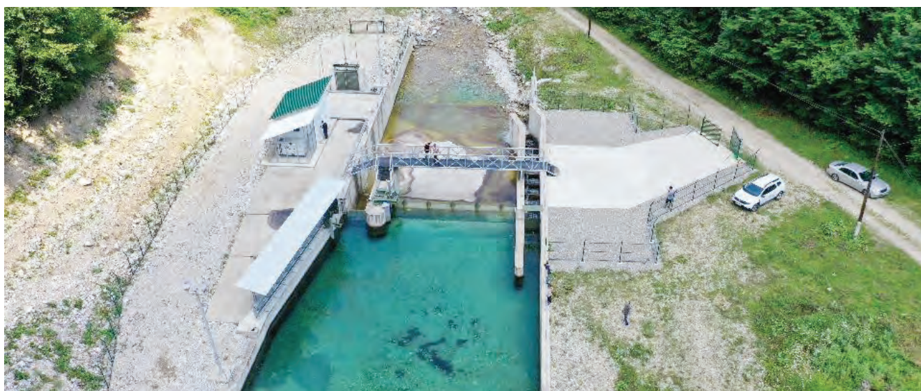
Slika 9. Objekat vodozahvata nakon igradnje - mHE „Bistrica Majstorovina“
