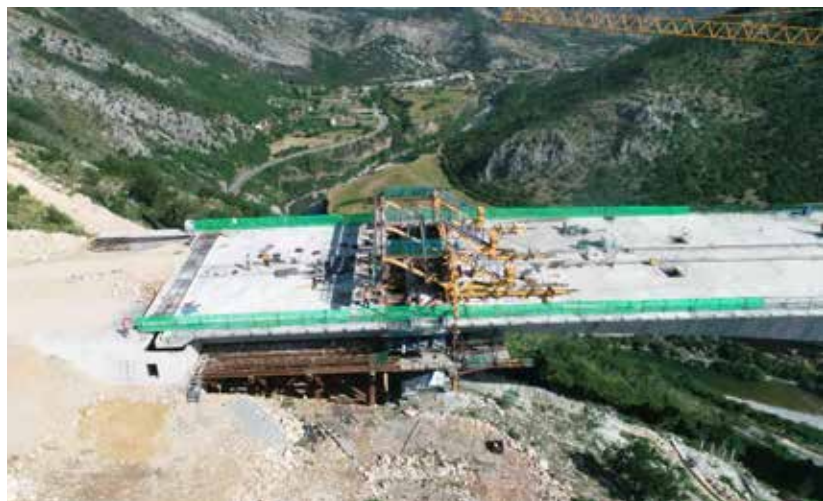
Spajanje mosta očekuje se u septembru, foro: Arhiva, CRBC
