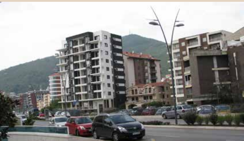
Budva kao paradigma bespravne gradnje i devastacije prostora
