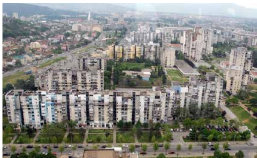
Pogled na Blok 5
