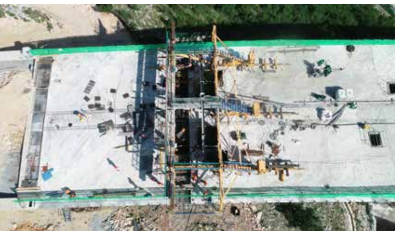
Most je rađen sistemom konzolne gradnje, foto: Arhiva, CRBC
