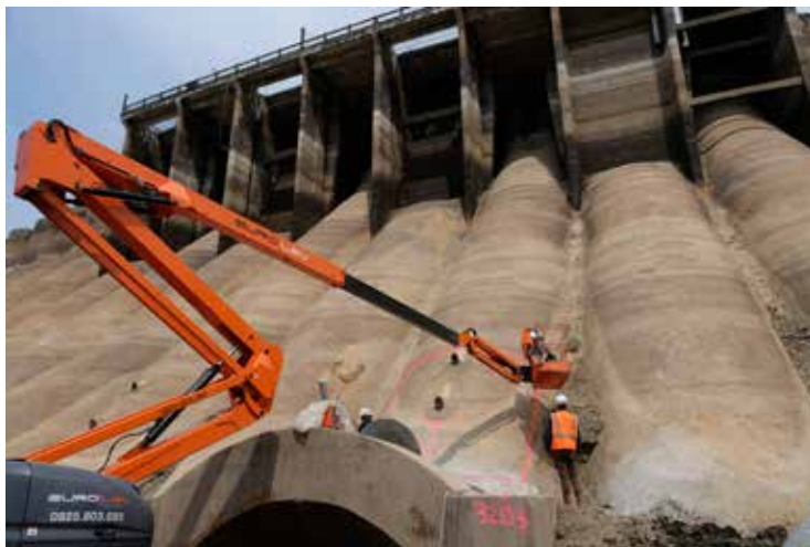
Uklanjanje hidroelektrane na rijeci Selin, foto: damremoval.eu
