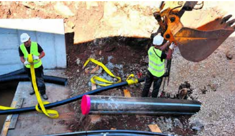
Postavljanje podmorskog kabla, foto: cdm.me
