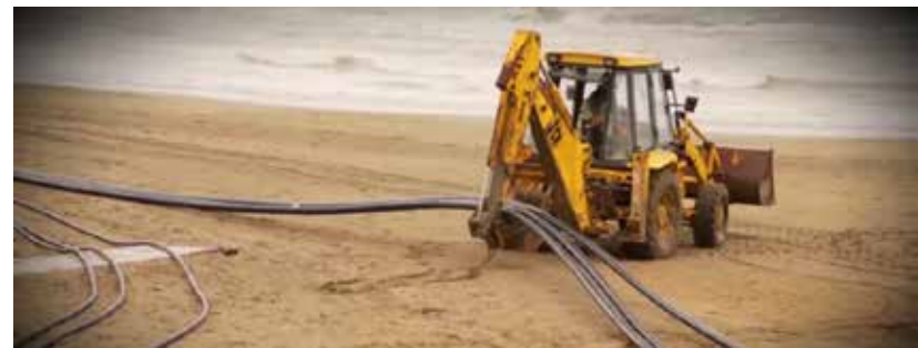
Proces postavljanja podmorskog kabla, foto: Terna
