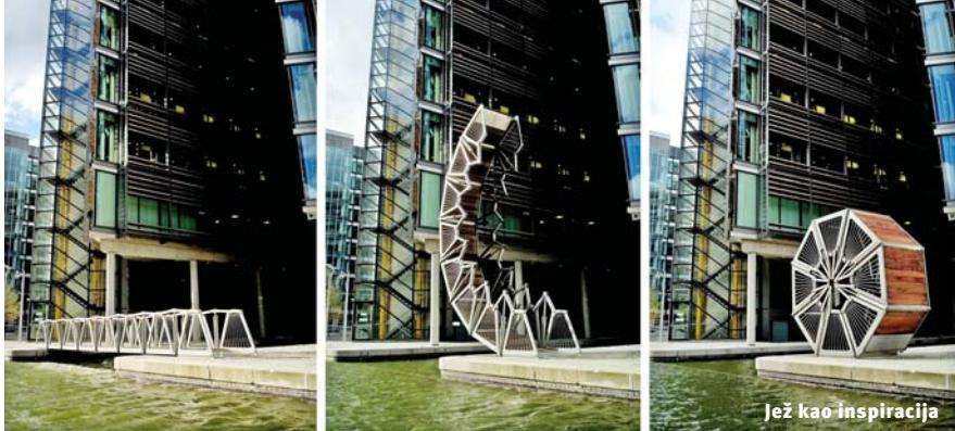
Tek nakon što se jedan kraj mosta počne podizati, postaje jasno zašto se o njegovom autoru često govori kao o velikoj zvijezdi britanskog dizajna. Struktura se polako i glatko otvara uz pomoć niza hidrauličnih kljunova integrisanih u ogradu mosta. Svaki od osam segmenata mosta
