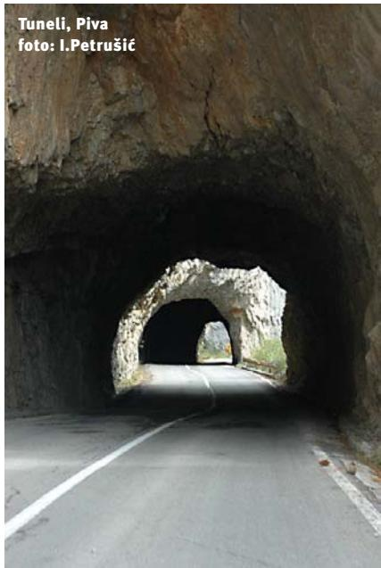
Kada je riječ o tunelima, treba istaći da pojedini tuneli na državnim putevima ne zadovoljavaju propisane tehničke standarde. U njima je smanjen saobraćajni profil, brojni od njih ne posjeduju hidroizolaciju i tunelsku oblogu, a na veoma malom broju tunela izvršeno je osvijetljavanje. Intenzivnija sanacija i rekonstrukcija tunela na magistralnim i
