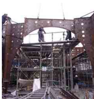
Spregnuta konstrukcija - čelični luk se pokriva armiranim betonom
