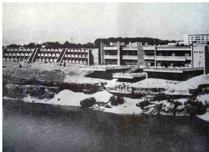
Hotel Podgorica neposredno nakon izgradnje
