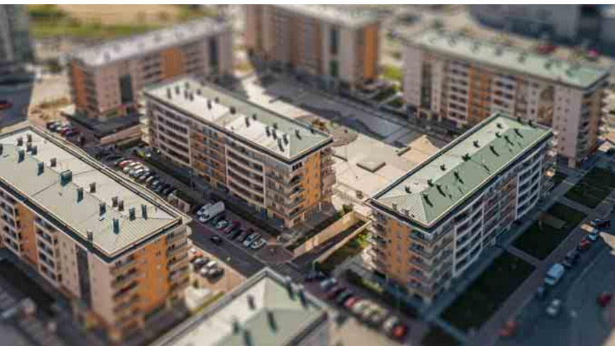
Kompanija Čelebić: Planirano i izvedeno stanje stambeno poslovnih zgrada Čelebić - City Kwart, foto: celebic.com
