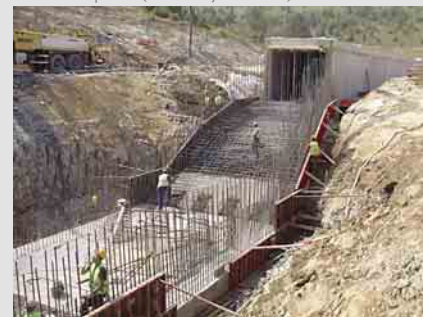
Izrada slapišta (izvođenje radova)
