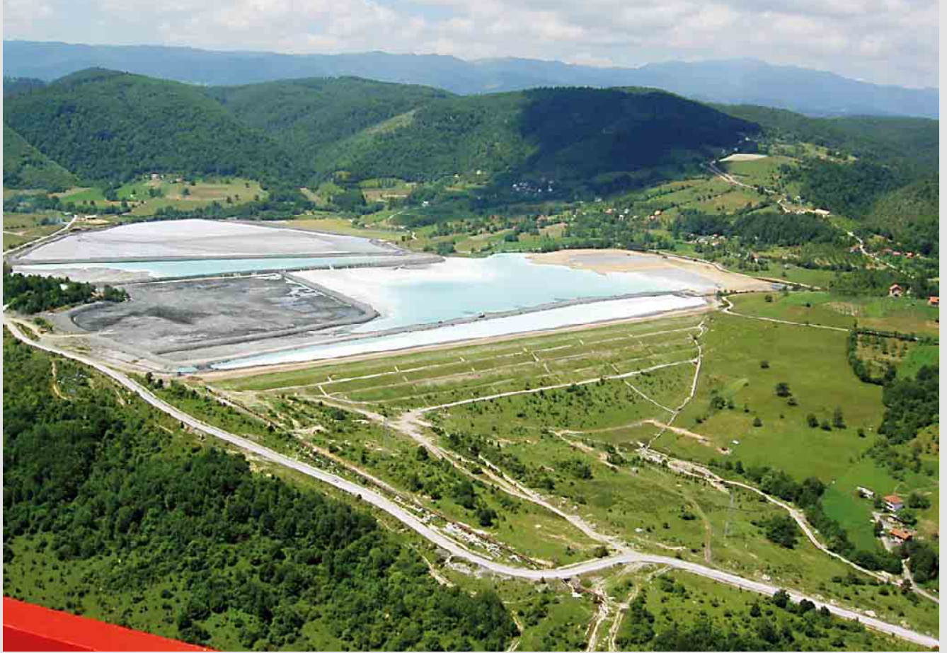
Nizvodno od brane Maljevac (stanje prije početka radova)
