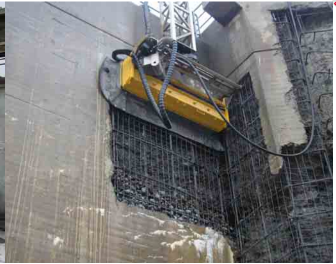
Moć robota "Ero" leži u snažnoj vodenoj pumpi, foto: archello.com
