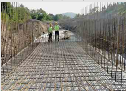
Izrada kolektora (izvođenje radova)
