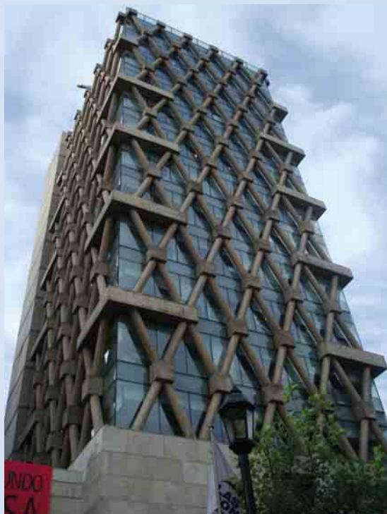
Konstrukcija definiše arhitekturu - fasada kao konstrukcija - Edificio Las Condes, Čile foto: wikimedia.org
