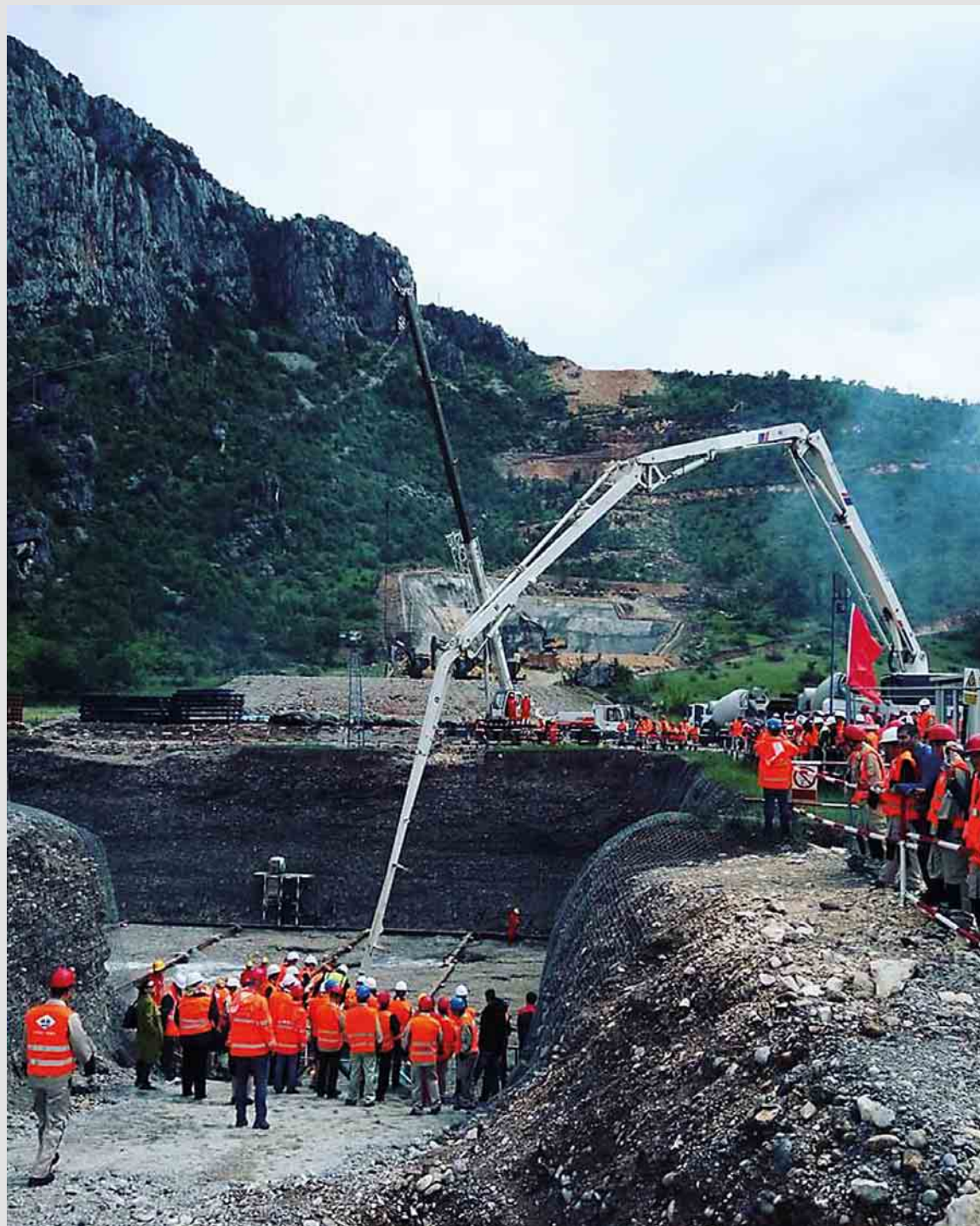
Izlivanje betona temeljnih jama mosta Moračica foto: crbcmne.com
