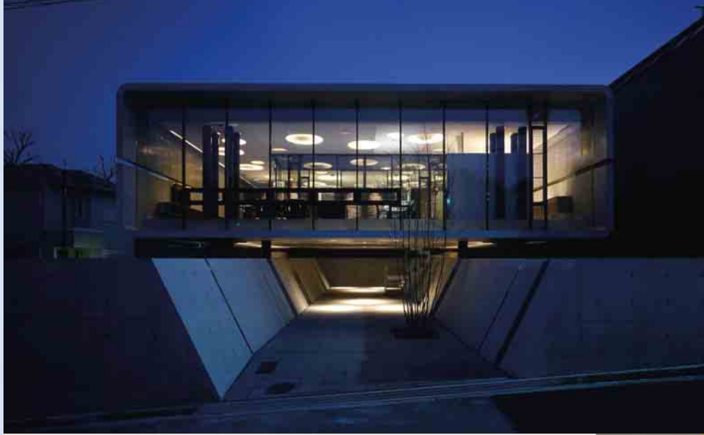
Television House u Osaki je primjer aseizmičke arhitekture, gdje su seizmički izolatori (bazna izolacija) istaknuti, odnosno vidljivi sa svih strana foto: architizer.com
