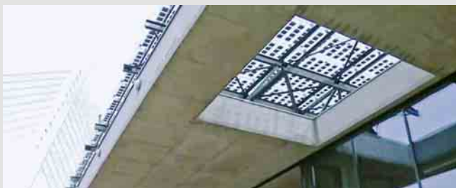
Na krovu su foto paneli za najapjanje električnom energijom
