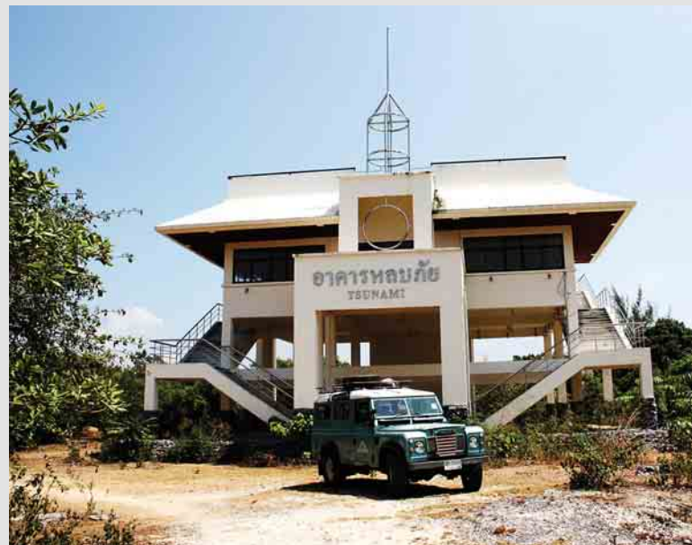
Objekat na plaži u gradu Pang na Tajlandu, okvirna konstrukcija sa otvorenim prizemljem kao zaštita od cunamija foto: netsolhost.com
