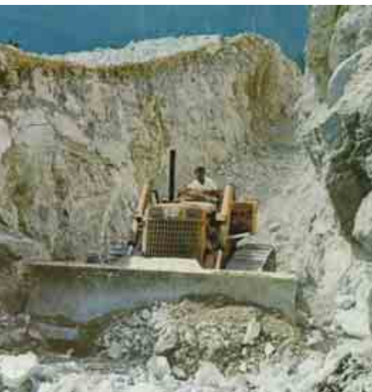
Sa gradilišta u niskogradnji
