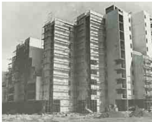
Gradilište Blok V u Titogradu
