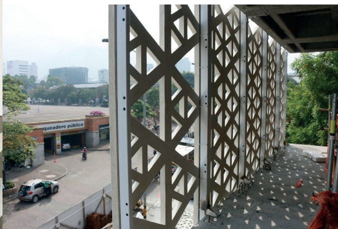
Spoljašnji sloj sastavljen je od visokokvalitetnih montažnih elemenata
