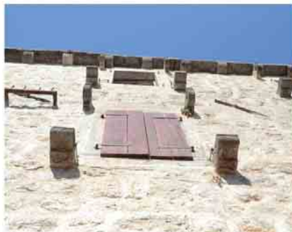
Stara građevina sa izbočinama na sjeverno dijelu gornjeg grada
