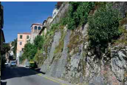
Pogled na zapadni zid iz Njegoševe ulice ka sjevernoj strani, drugi dio
