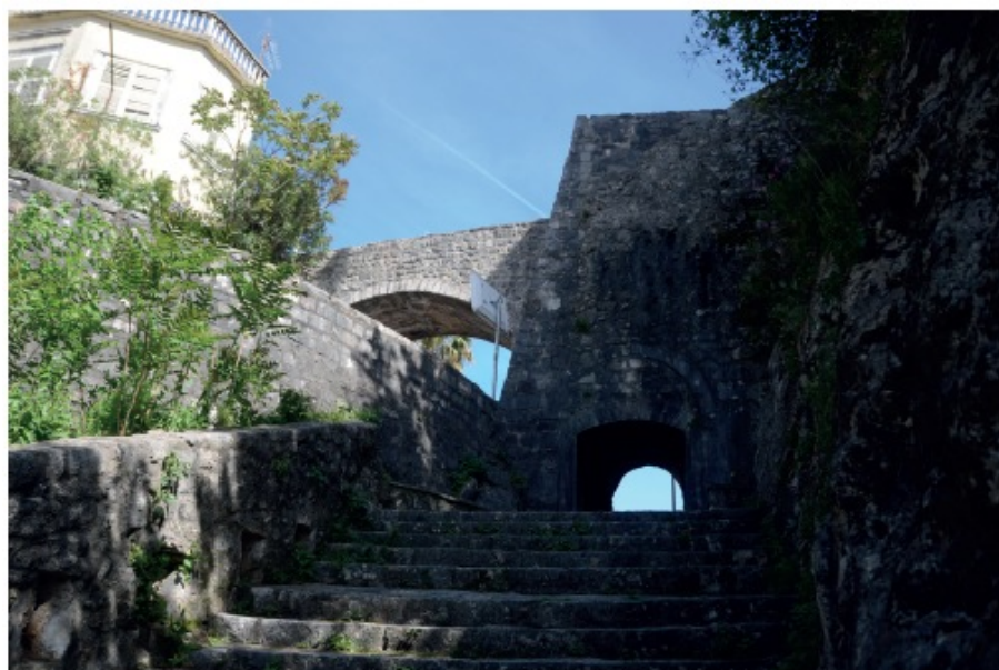
Pogled sa prolaza ispod potpornog zida vrata kroz koja se ide do tvrđave
