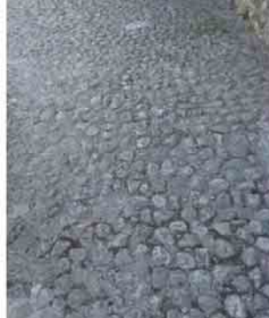
Stari način pokrivanja, sitno postavljanje kamena
