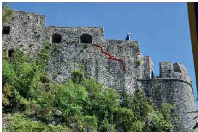
Pogled sa mosta na fasadu na zapadnoj strani Forte Mare
