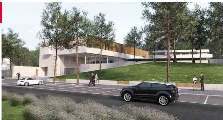
Studio Grad, pogled na objekat, u pravcu sjeverozapada
