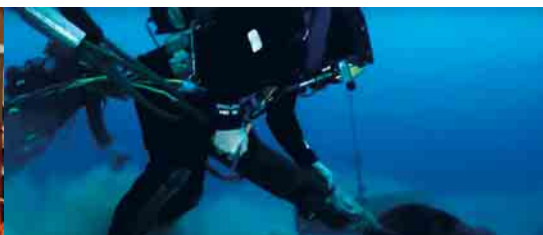
Postavljanje podvodnog kabla foto: cges.me
