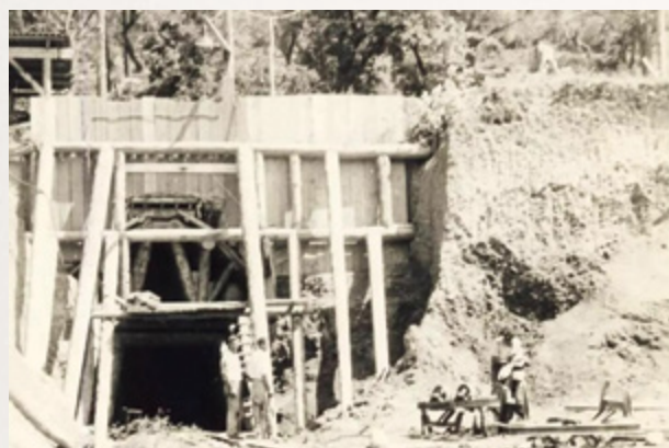
Probijanje željezničkog tunela „Sozina“, početni radovi 1953, foto: Arhiva ŽICG
