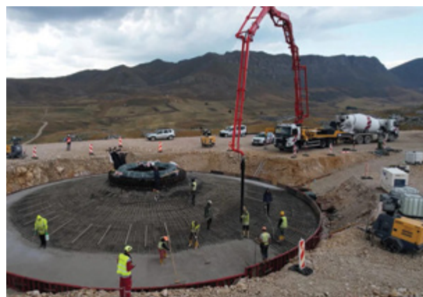
Gradnja temelja za turbine vjetroparka Gvozd, foto: bemax.me
