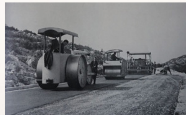
Izgradnja Jadranske magistrale, izvor: Ivica Radoš, Sveučilište Zadar
