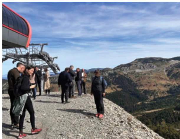
Obilazak gradilišta planinskog centra „Hajla“, foto: ingkomora.me
