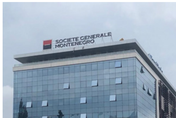
Objekat poslovnog prostora „Societe Generale Bank”, foto: media.licdn.com
