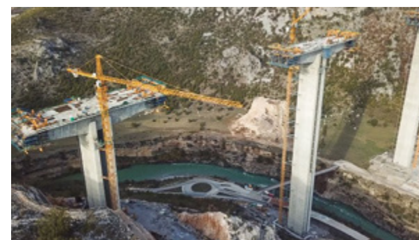
Izgradnja mosta Moračica, foto: monteput.me
