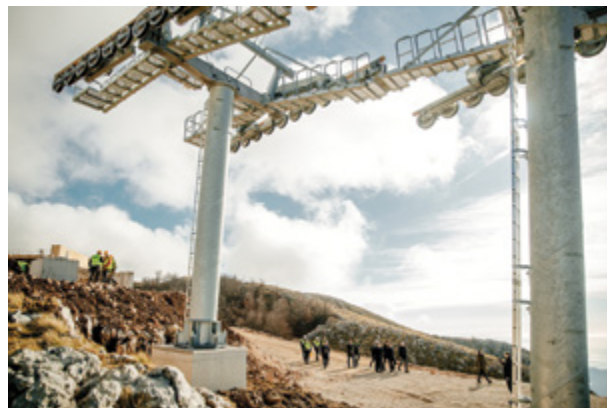
Izgradnja žičare Kotor-Lovćen, foto: briv.me
