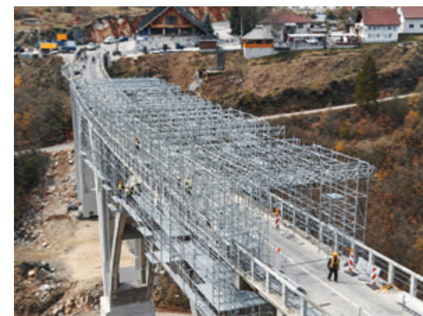
Radovi na rekonstrukciji mosta na Tari, foto: tvpljevlja.me
