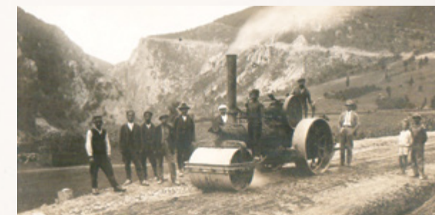
Izgradnja puta Berane-Bijelo Polje, foto: in4s.net
