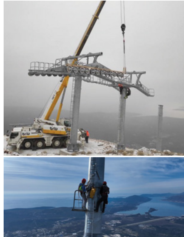
Montiranje čeličnih stubova na strmim liticama, foto: briv.me
