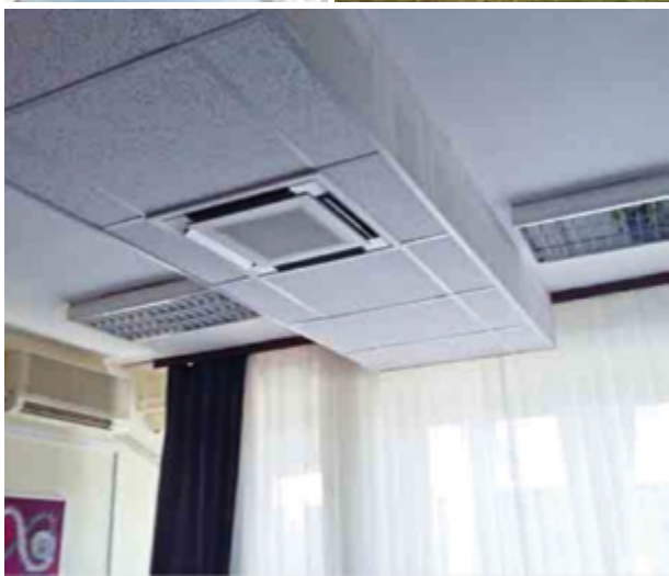
Detalji radova obuhvaćenih nagrađenim projektom, foto: Privatna arhiva
