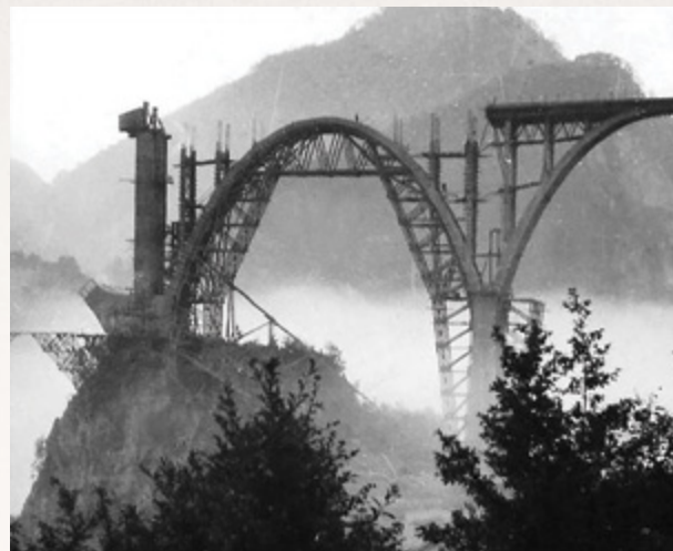
Gigantska drvena skela visoka 141 metar, foto: sharemontenegro.me
