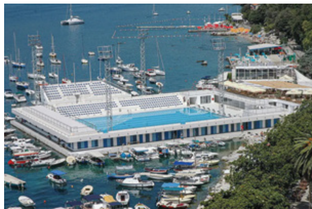
Bazen na Škveru nakon rekonstrukcije, foto: Jadran.me
