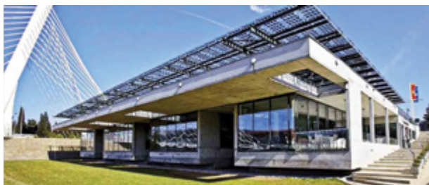
Detalj Eko-zgrade UN u Podgorici, foto: Privatna arhiva
