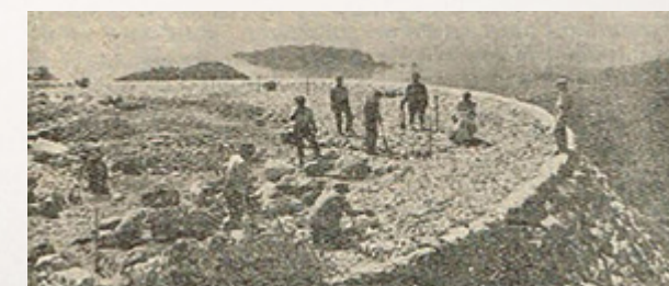
Izgradnja puta Cetinje-Budva, foto: monenegrina.net
