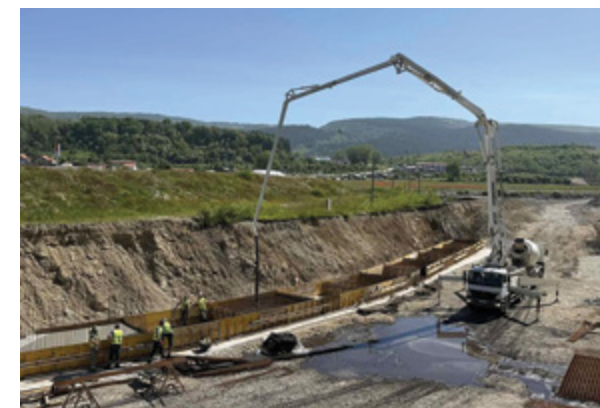
Radovi na izmještanju rijeke Čehotine, foto: RUP
