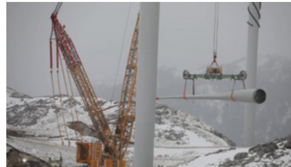
Postavljanje najvećeg vjetrogeneratora u Evropi, Gvozd, foto: epcg.me
